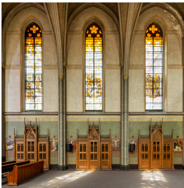
Zijaanzicht van de schiptraveeën met per travee een eenduidige opbouw bestaande uit een biechtstoel geflankeerd door kruiswegstaties en daarboven een hoog, smal venster met beschilderd glas-in-lood.
